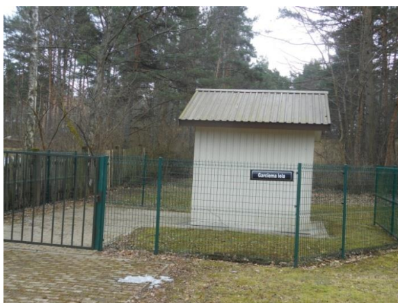
15.attēls. Kanalizācijas sūkņu stacija pie Garciema un Liedaga ielas krustojuma
