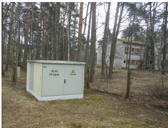
14.attēls. 20kV transformatoru apakšstacija pie lokālpilnvarojuma teritorijas (Garciema ielā)
